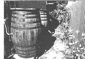
⑥ウイスキーの廃樽利用の雨水タンク。雨水はトイレと庭の撒水に使われる
